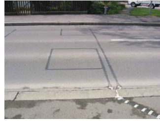
Druckschlauch (auf Fahrbahn geklebt)
