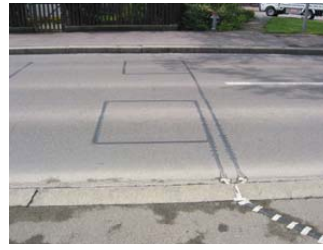
Druckschlauch (auf Fahrbahn geklebt)
